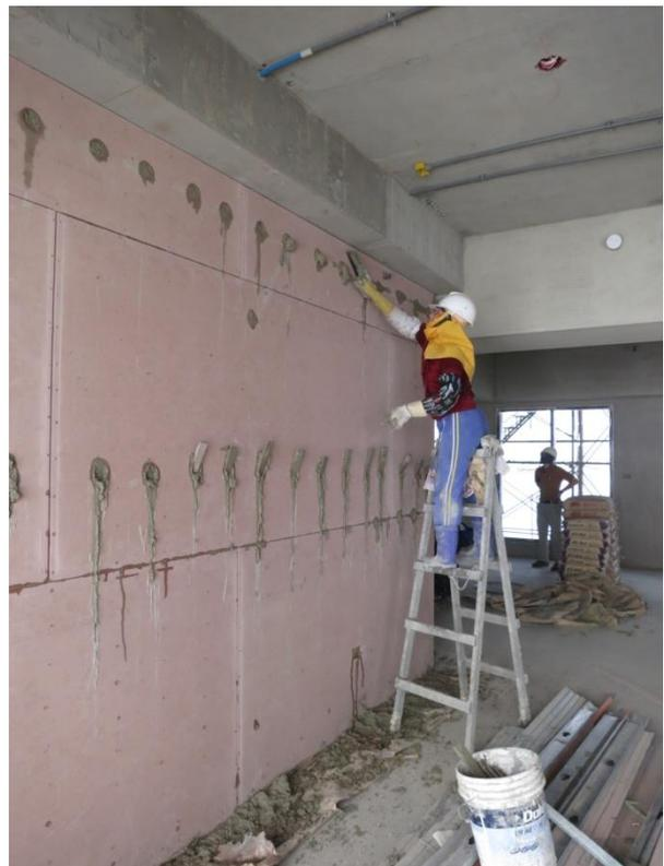
裝修工程輕隔間砂漿刮除
