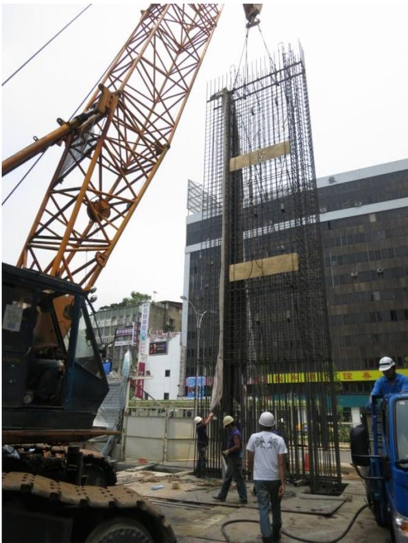
基礎工程工地吊放鋼筋籠
